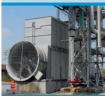
Installations de refroidissement par dispersion d'eau dans un flux d'air (tours aéroréfrigérantes)
